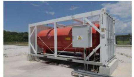
Tanque de hidrógeno de 12 m³ usado en el proyecto de demostración de REMOTE de Agkistro, Grecia (Fuente: Documentación enviada a NESOI)
